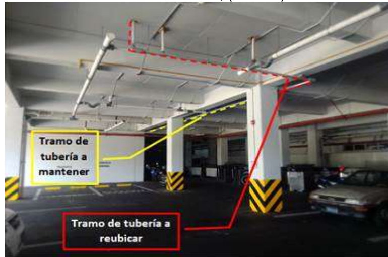
Figura 10.18. Esquema de ubicación de acometida existente hacia concesionario.
