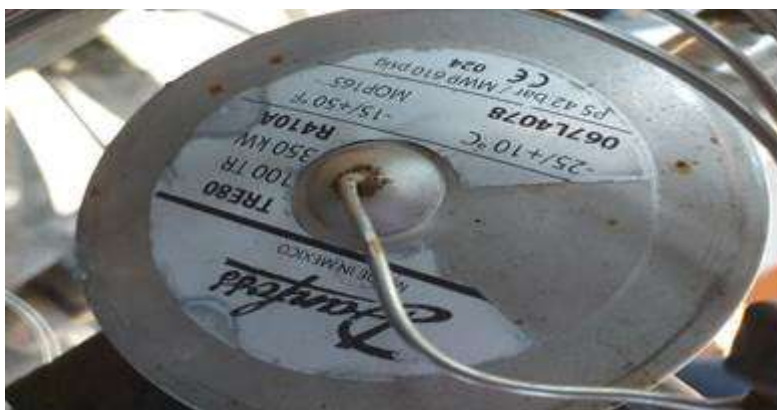
Válvula de expansión termostática.
