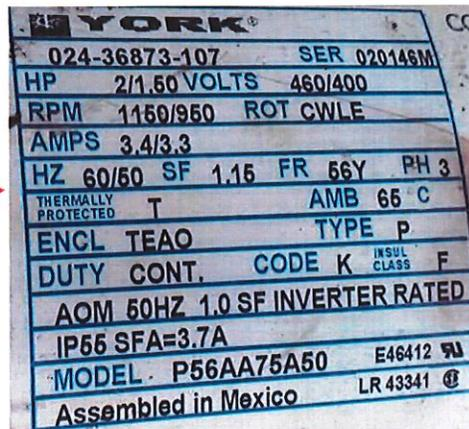
MOTORES ELECTRICOS DE 2 HP DE 460/400 VOLT A 1150/950RPM, 2 VELOCIDADES
