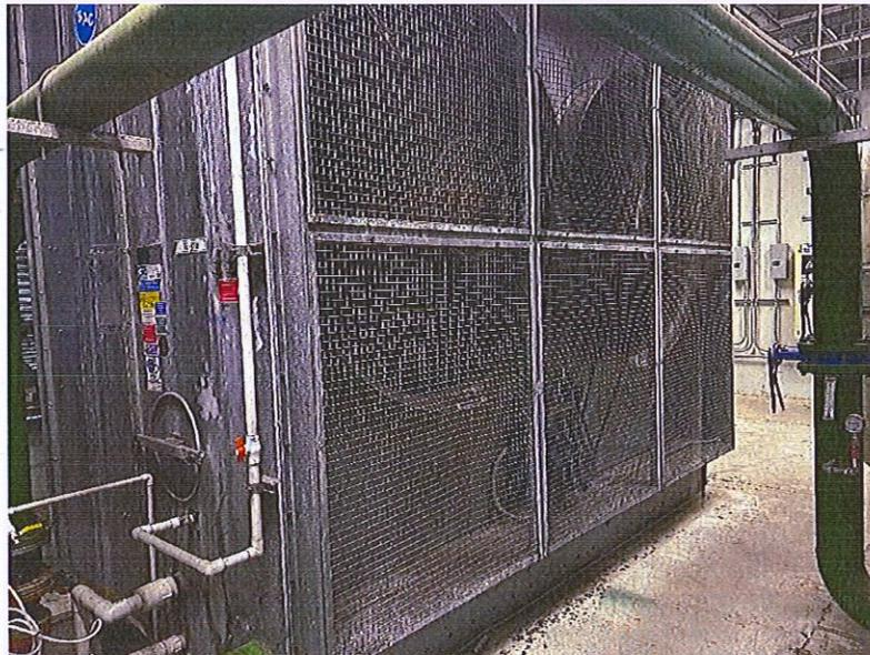
Ilustración 4. Motor de ventilación de la torre de enfriamiento
