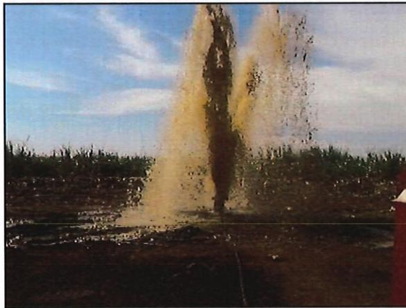
Fig. 1 -La imagen arriba muestra limpieza con aire comprimido. Pozo sucio
