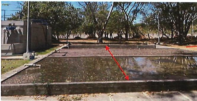
Patios de secado planta de aguas residuales PTAR
