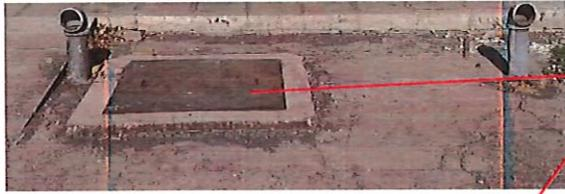
Trampa de aceite que conecta la red hidráulica del taller automotriz con la red de aguas residuales
